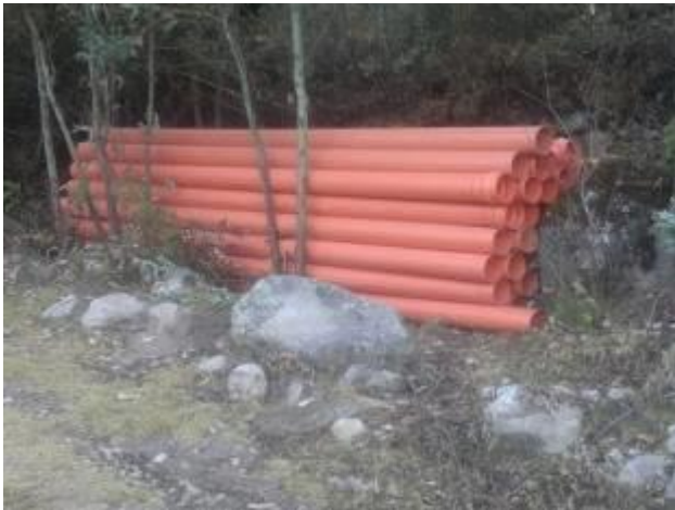
Tubería depositada cerca a la localidad de Rimash, cubierta con ramas de eucalipto para evitar el deterioro por la radiación UV antes de su instalación.
