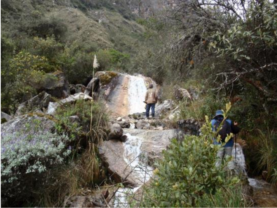
Zona de la bocatoma y del inicio del canal de conducción antes de ejecutar las obras.
